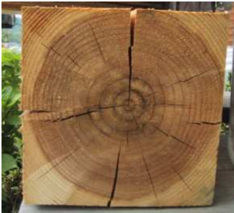
図 3.2: 木材におこる心割れ、目まわり (©(有) 栗駒建業 [21])
